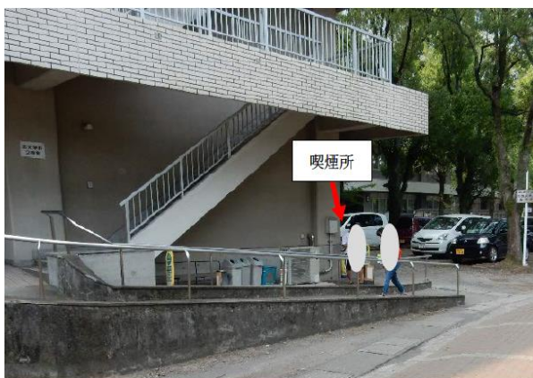
図3 建物への出入りの様子（非喫煙者が利用するエリアと屋外喫煙所との間に十分な距離が確保されておらず，非喫煙者が喫煙所からたばこの煙のばく露を受けるおそれがある）：報道資料のまま
